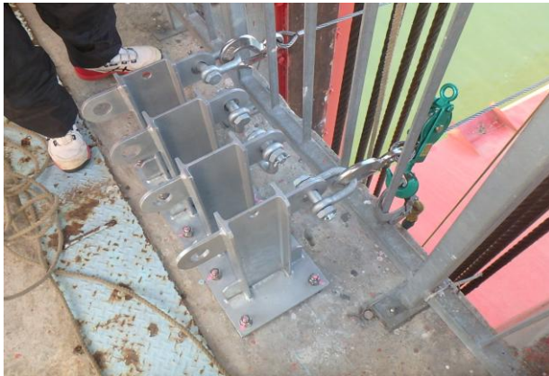
⑮ 左岸側 ワイヤロープ設置完了
