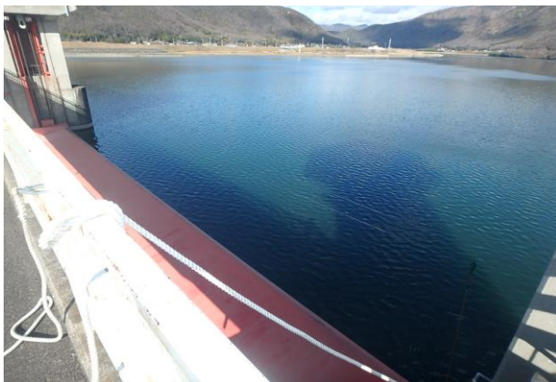
⑱ ワイヤロープ設置完了
