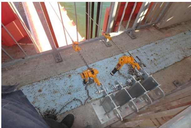
⑯ 右岸側 ワイヤロープ設置完了
